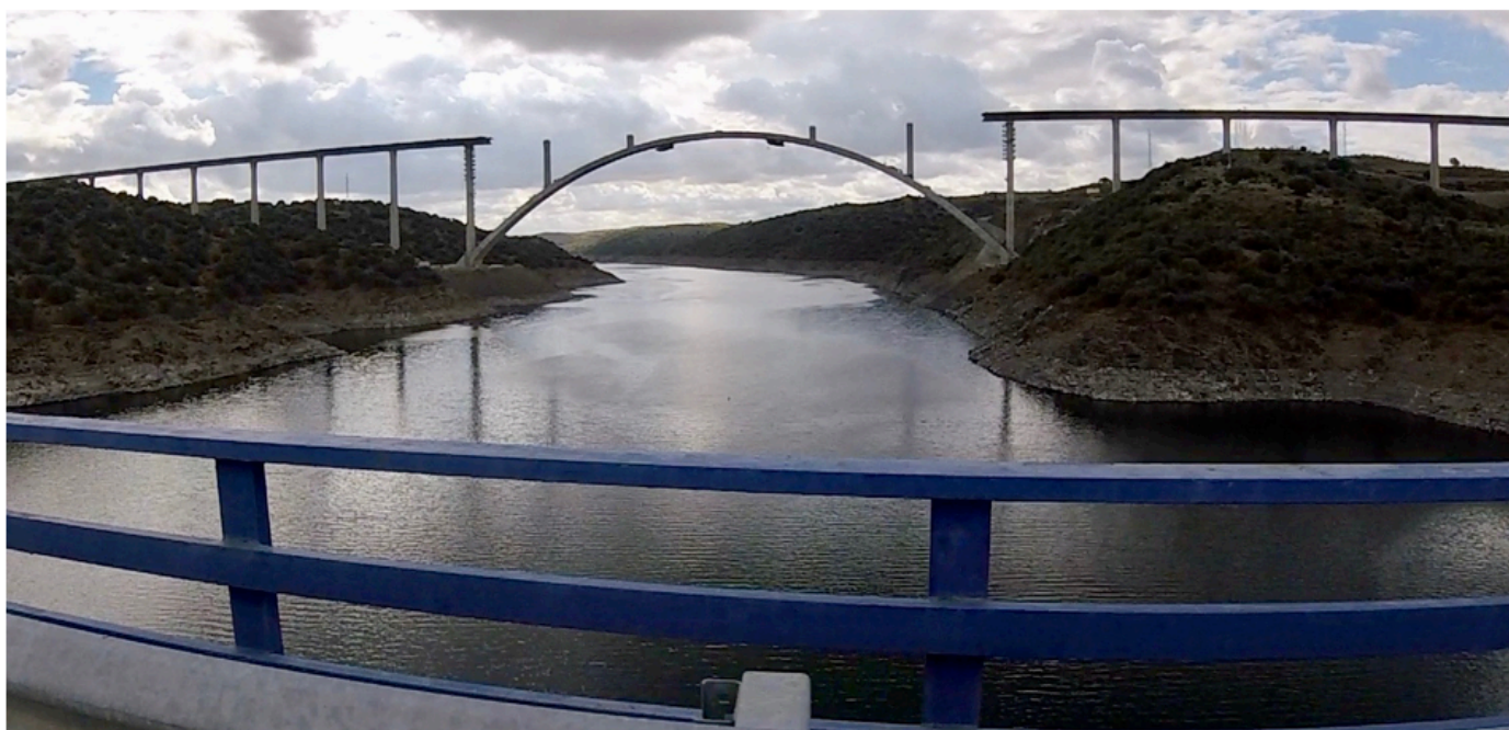
De Taag, waarover een brug voor de HSL in aanbouw
