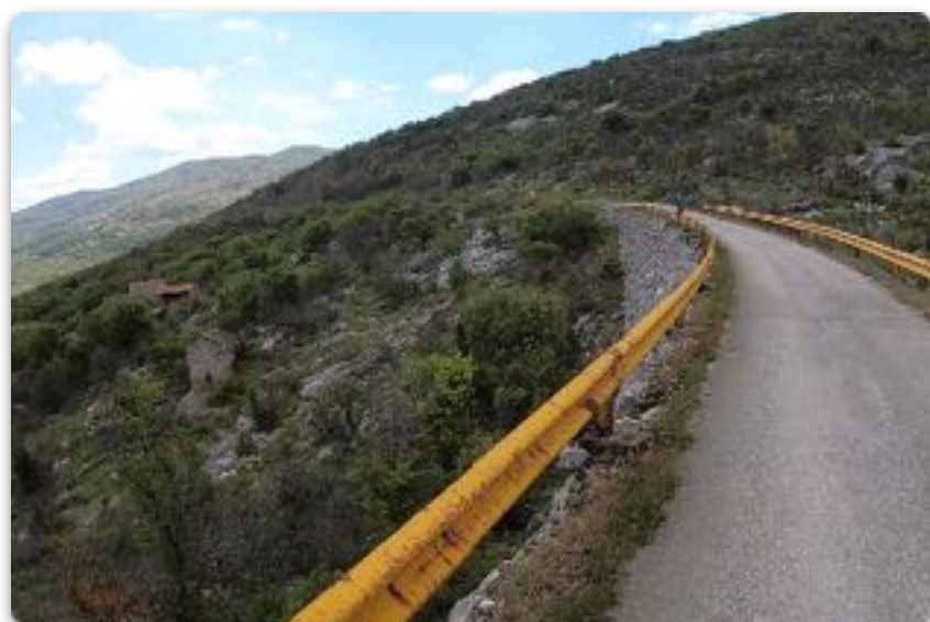
Talud Giro Ruta
